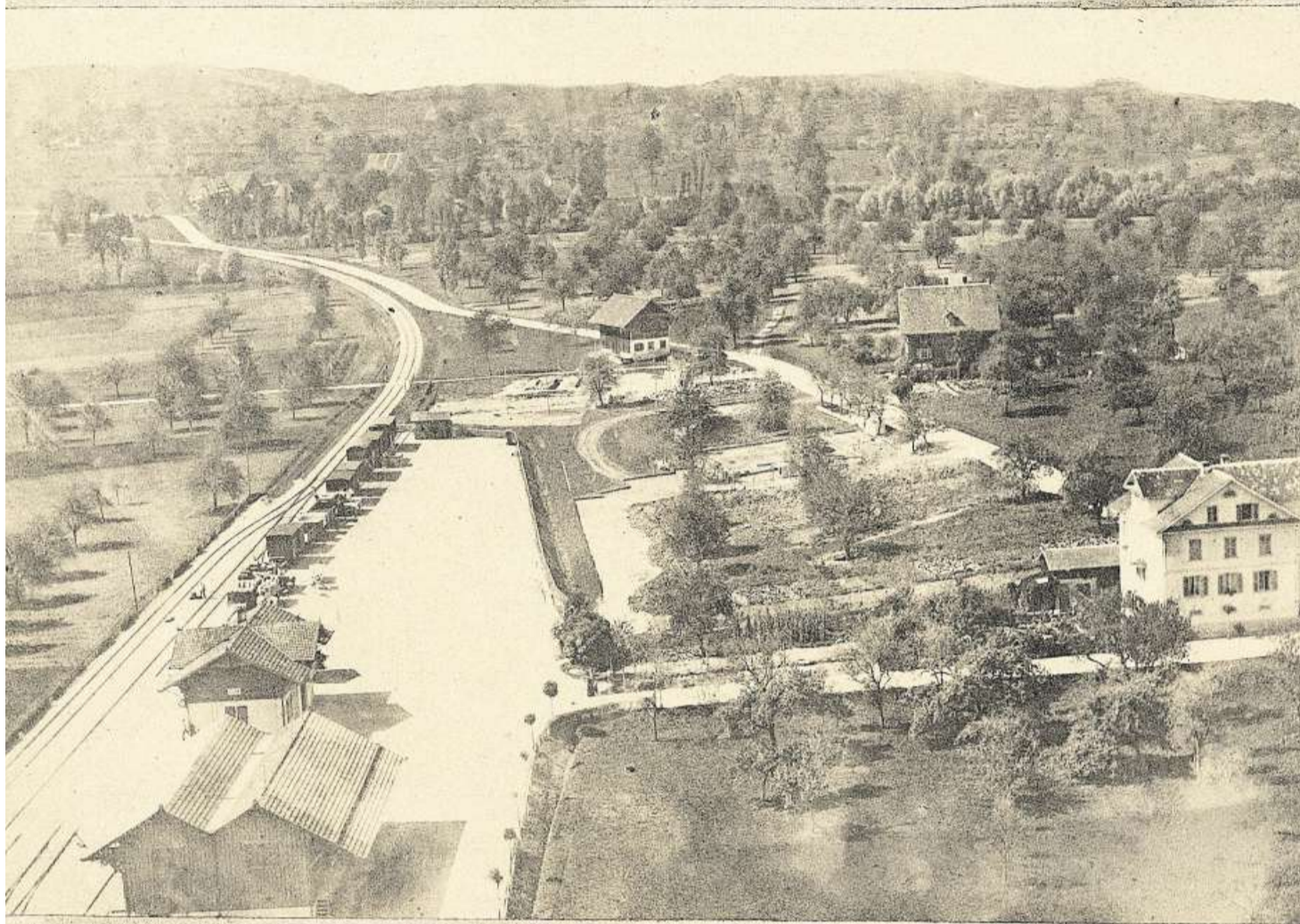
Die einzige bekannte Gesamtsicht des ersten Bahnhofes in Cham stammt von 1877 und zeigt den Bau des Lagerhauses der Anglo-Swiss. Das Verbindungsgeleise wird 1879 mit einer Drehscheibe an das Auszugsgeleise, auf welchem die Güterwagen stehen, angeschlossen werden.
